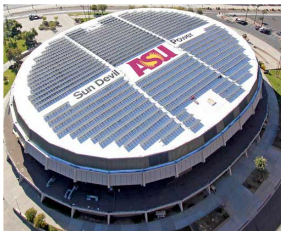
Slika 3: Arizona Univerzitet, Wells Fargo Arena, prekrivena solarnim panelima
