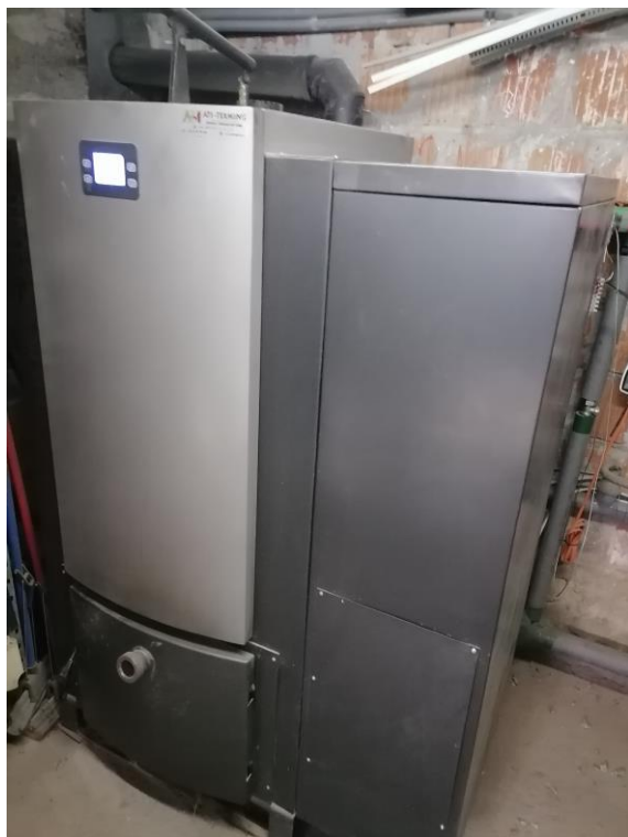
Слика бр:8. Котао АТИ Терминг ОЗОН 35 – експериментално место бр.1
