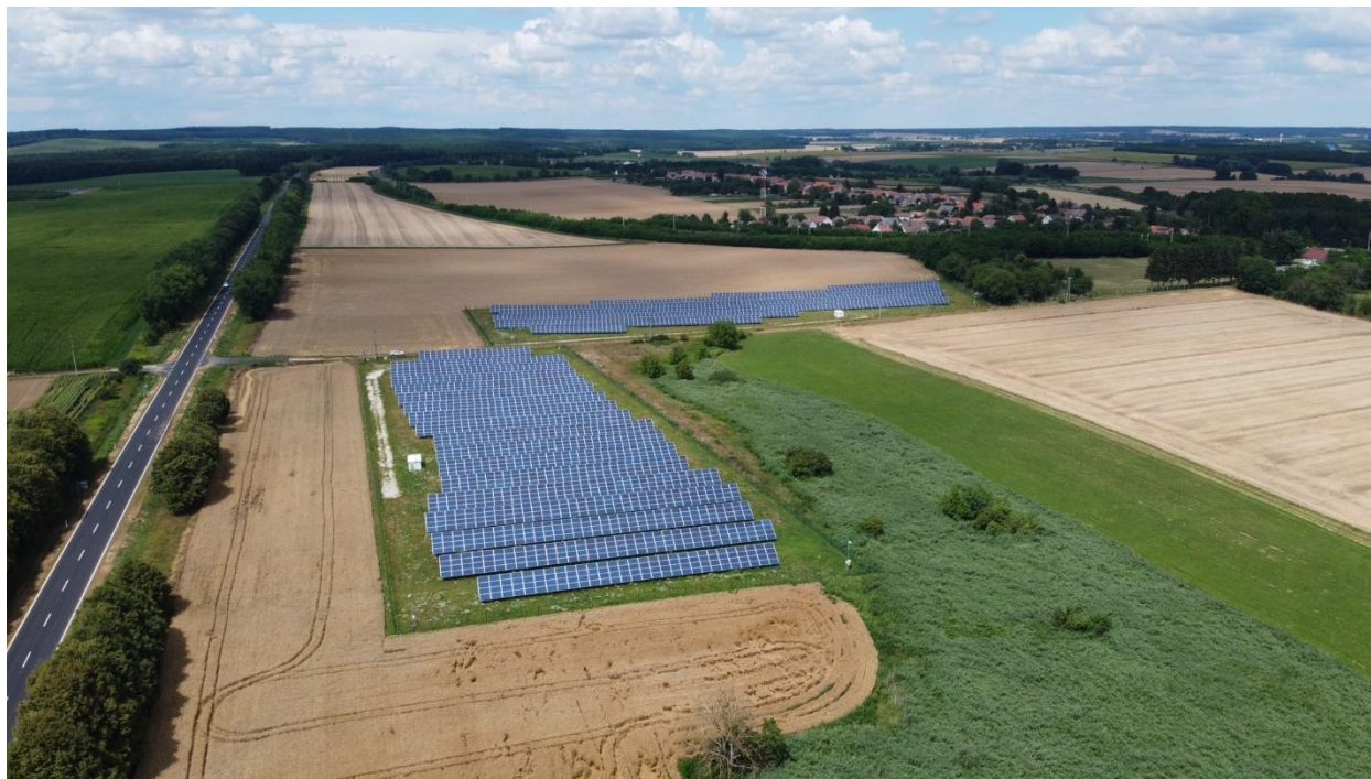
Slika 3. Solarna elektrana u Győrváru (Mađarska) – primer instalacije fotonaponskih panela u ravničarskom području.
